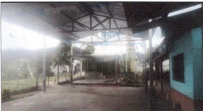
Foto 4: Mejoramiento de techo del patio
