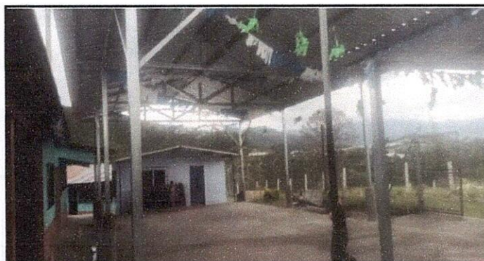
Foto 3: Mejoramiento de techo del patio
