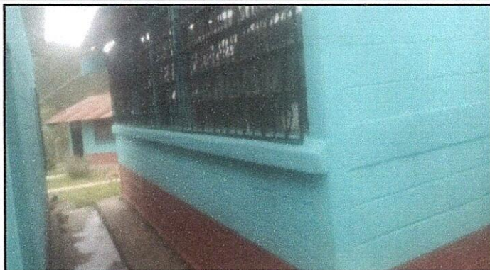
Foto1: Mejoramiento de pintura
