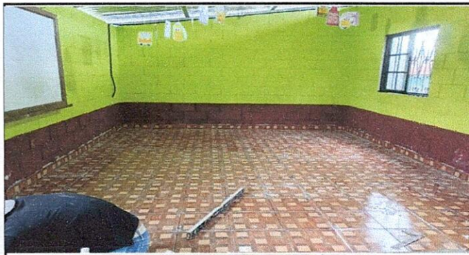
Foto 6: Mejoramiento de piso ceramico
