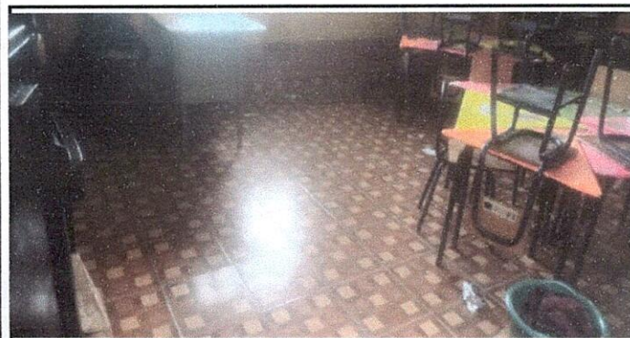
Foto 5: Mejoramiento de piso ceramico
